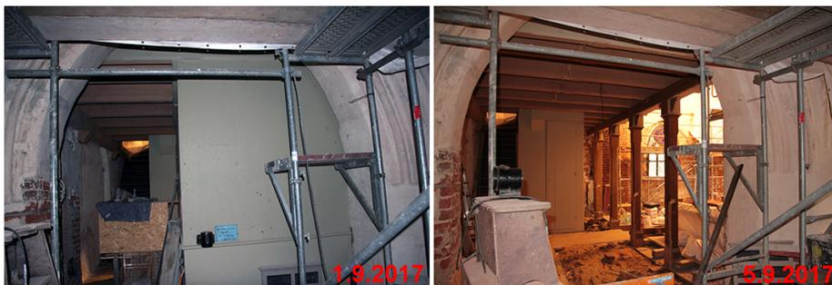
Nach dem Rückbau der Verkleidungen unter der Orgelempore erwartet die Besucher beim Hineingehen in die Behrenhoffer Kirche ein ganz neuer Raumeindruck. Zurzeit ist das Innere eine einzige Baustelle. Elektroleitungen für Licht, Tontechnik und Heizung werden verlegt, die Wandflächen im Kirchenschiff werden neu verputzt, ebenso die Gewölbe und Wände im Seitenschiff. Die Fußböden werden erneuert und ergänzt. Mit Beginn des neuen Kirchenjahres, ab Advent, gibt es dort wieder regelmäßig Gottesdienste.
